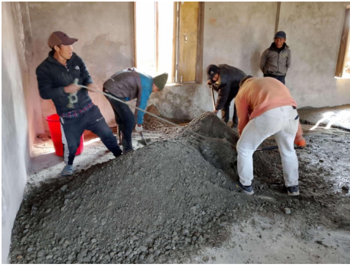
Coulage de la chape intérieure
