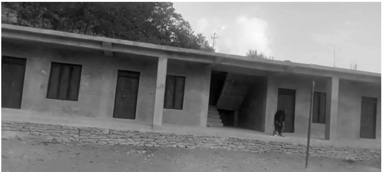
Les menuiseries mises en place
