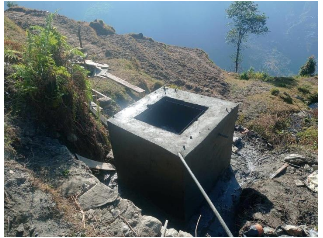
captage bétonné de la source et mise en place des aciers pour le réservoir
