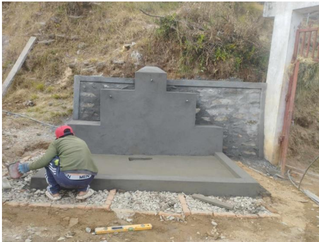
Construction du mur de soutènement et de la fontaine , l'eau coule désormais
