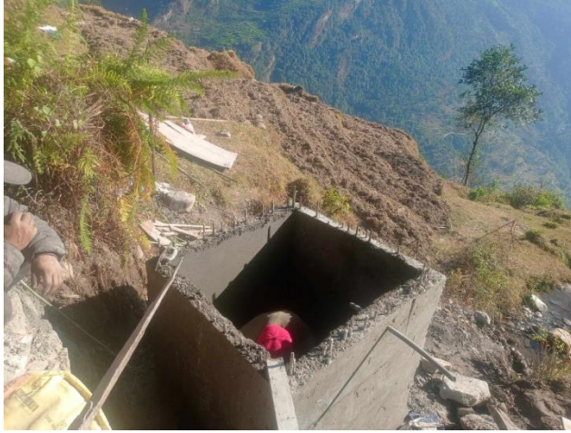
captage bétonné de la source et mise en place des aciers pour le réservoir
