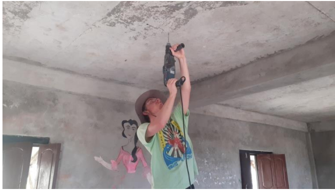
Perçage pour installation des luminaires et câblage des interrupteurs
