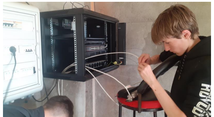
Cablage du réseau électrique et internet avec les différentes armoires
