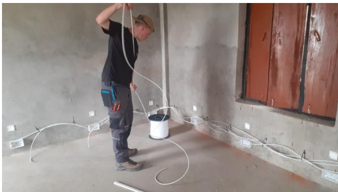
Cablage du réseau électrique et internet avec les différentes armoires
