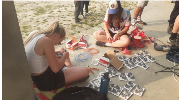
Perçage pour installation des luminaires et câblage des interrupteurs
